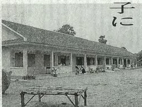
完成したトレア小学校の新社舎
